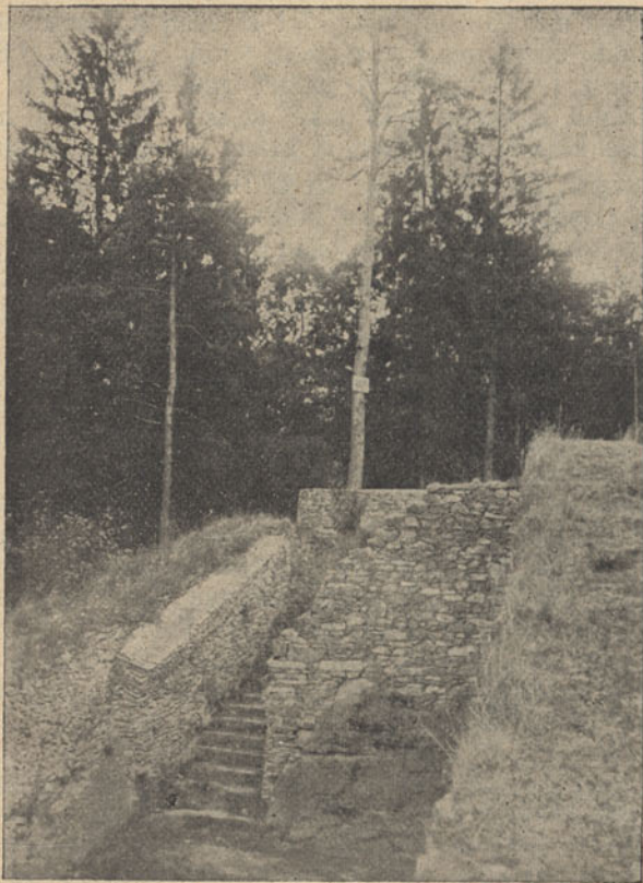
(Obr. 3.) Schody a studňa na Kozím.
